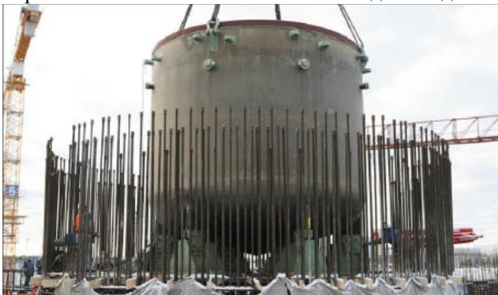
Монтаж корпуса ловушки расплава ЛАЭС-2
